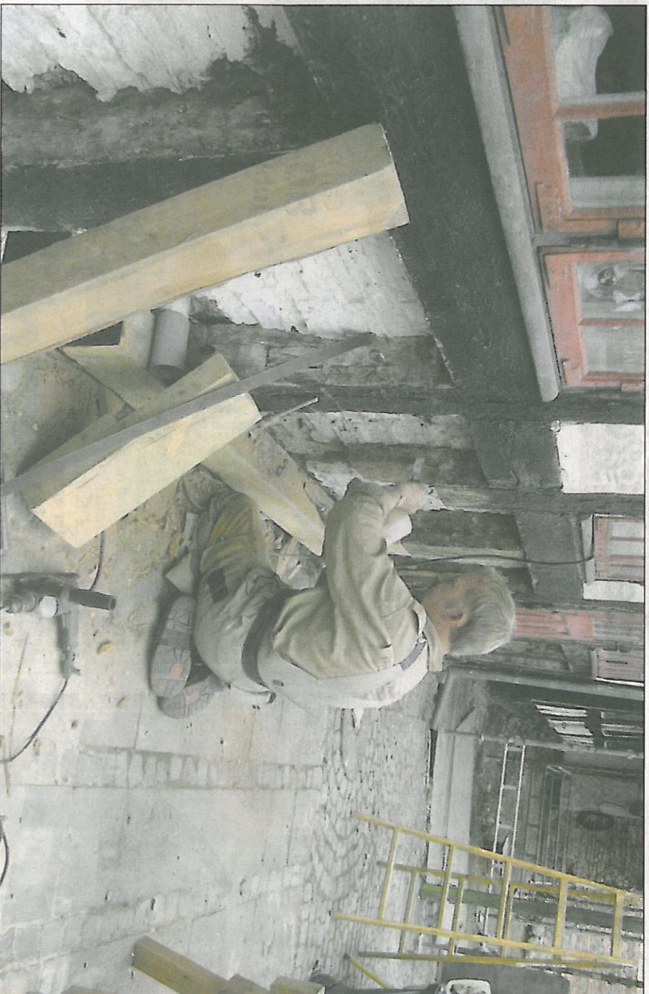
Jens Led fra Tømmer/Snedkerfirma Henning Hansen i Hjørte ved Gelsted på Fyn har specialiseret sig i at arbejde med bindingsværk efter de gamle teknikker og arbejder i disse dage på renoveringen af den fredede 'Gammelgaard' i Husby.
